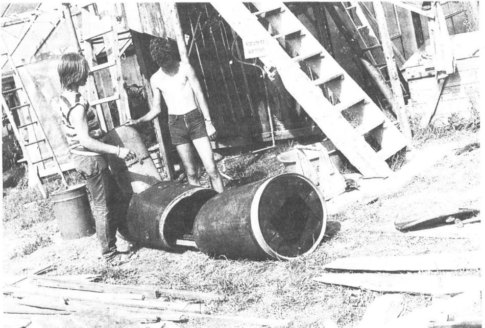
Beim Zusammenbau des Behälters. Links: angesetzter Schacht, rechts: Loch f. Klappe.
