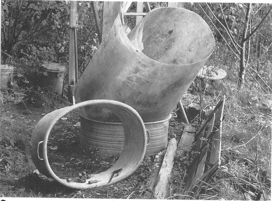
Bau des Behälters aus Zinkwannen und Plast-Dach-Müll
