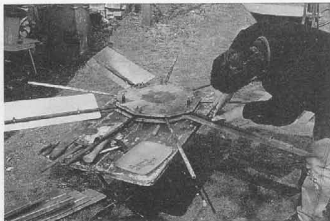
Blechflügel mit Schlauchschellen montieren & ausrichten.
